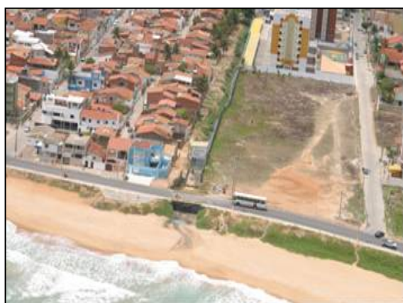
Depois das obras de barramento.
