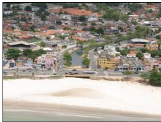
Depois das obras de barramento
