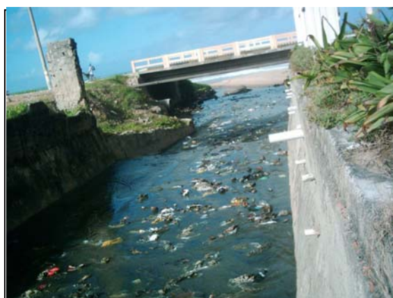
Situação depois das obras de barramento, em período chuvoso.
