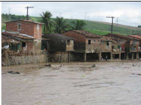
Metade da casa sobre as águas na cidade de Rio Largo, revelando a precariedade do disciplinamento do uso e ocupação do solo no quesito prevenção aos danos provados pelas enchentes (21/07/2010).
