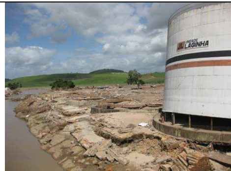
Na Usina Laginha, localizada em União dos Palmares, havia 6 tanques de álcool, cada um com capacidade para 1.200 m 3 . Cinco tanques foram levados pela enchentes por mais de 25 km. Apenas um resistiu parcialmente. Observa-se que os tanques estão a menos de 3 metros do leito menor do rio (21/07/2010).
