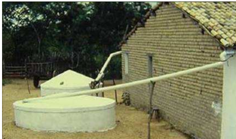
Figura 1. Cisterna implantada no semi-árido brasileiro. FONTE: CIRILO (2008).
