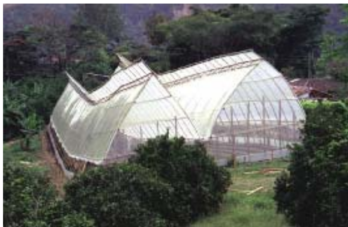
Ilustração 50: Estufa construída com estrutura em bambu. Fonte: VÉLEZ, 2002.
