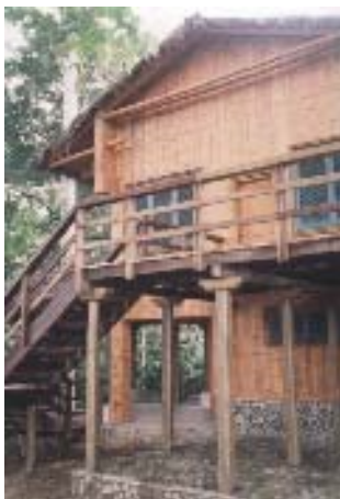
Ilustração 42: Exemplo de casa construída parcialmente em bambu no Equador - paredes e a tesoura do telhado em bambu.
