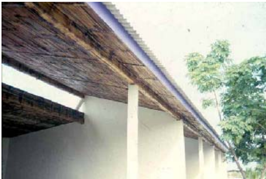
Ilustração 78: Bambu usado em forro de telhado numa residência.
