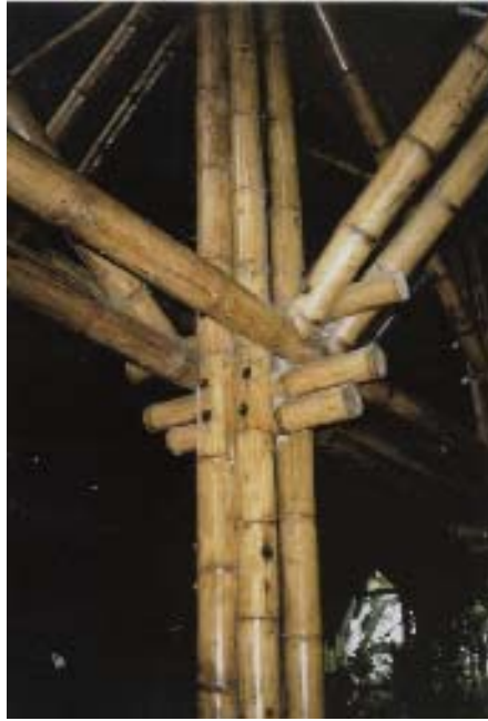
Ilustração 38: Amarração entre vigas e colunas de bambu – estrutura de coberta.
