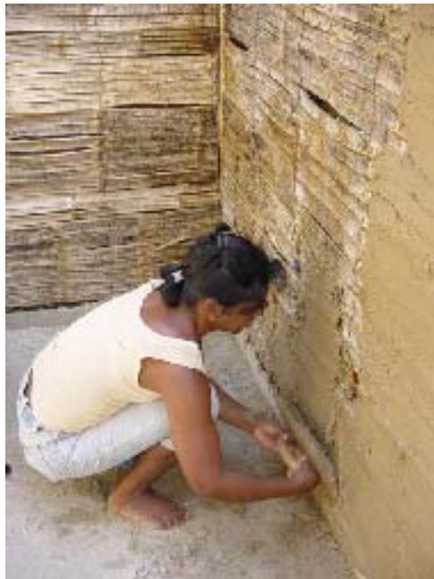
Ilustração 66: Mulher da comunidade trabalhando na construção do protótipo de Padre Pinho em Maceió.
