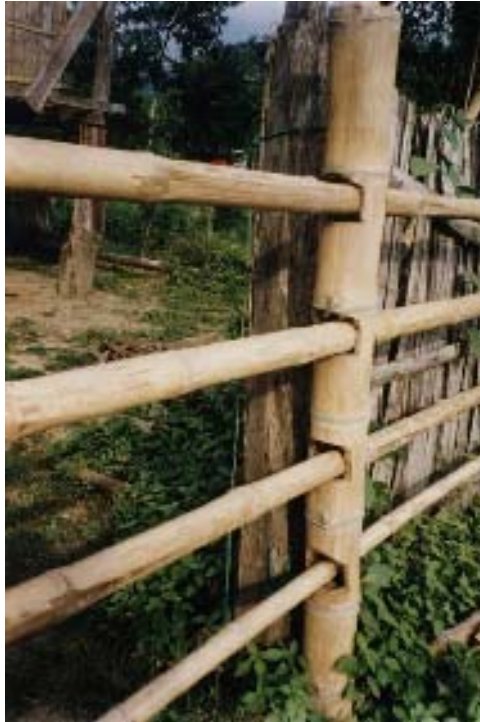
Ilustração 70: Bambu usado na construção de uma cerca.
