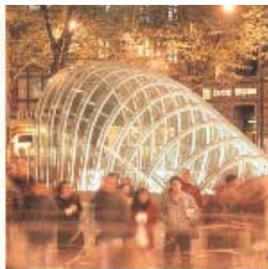
Entrada do metrô de Bilbao, por Norman Foster – inspiração oriental.
