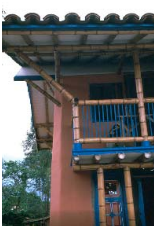
Ilustração 69: Bambu usado na estrutura de uma varanda – vigas, colunas, guarda-corpo e telhado.
