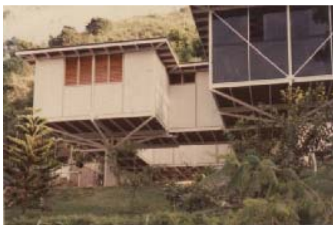
Ilustração 43: Exemplo de casa construída parcialmente em bambu no Equador - sistema construtivo de bambu e concreto.
