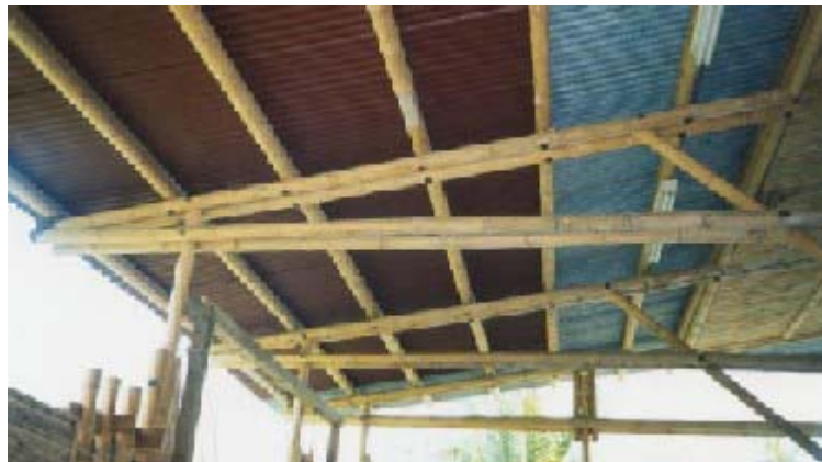
Ilustração 73: Bambu usado na estrutura de telhado – casa ecológica construída no Rio de Janeiro
