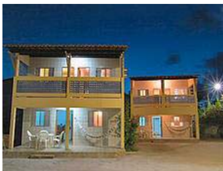
Ilustração 61: Fachada de residência em Barra de São Miguel – observa-se os elementos de proteção solar: grandes beirais, varandas e elementos vazados.
