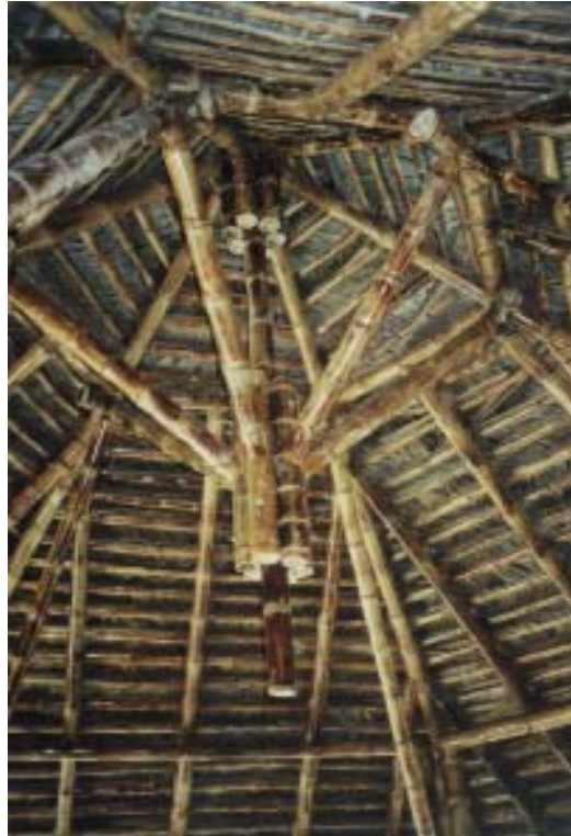
Ilustração 72: Bambu usado na estrutura de um telhado.
