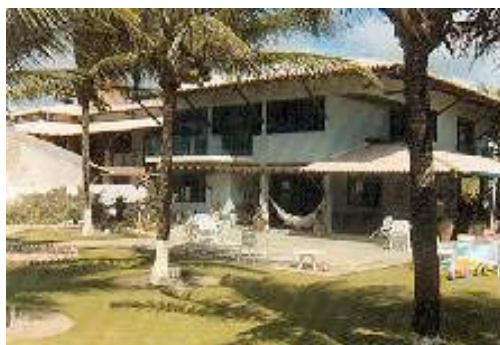
Ilustração 62: Fachada de residência em Barra de São Miguel – observa-se os elementos de proteção solar: grandes beirais e varandas.
