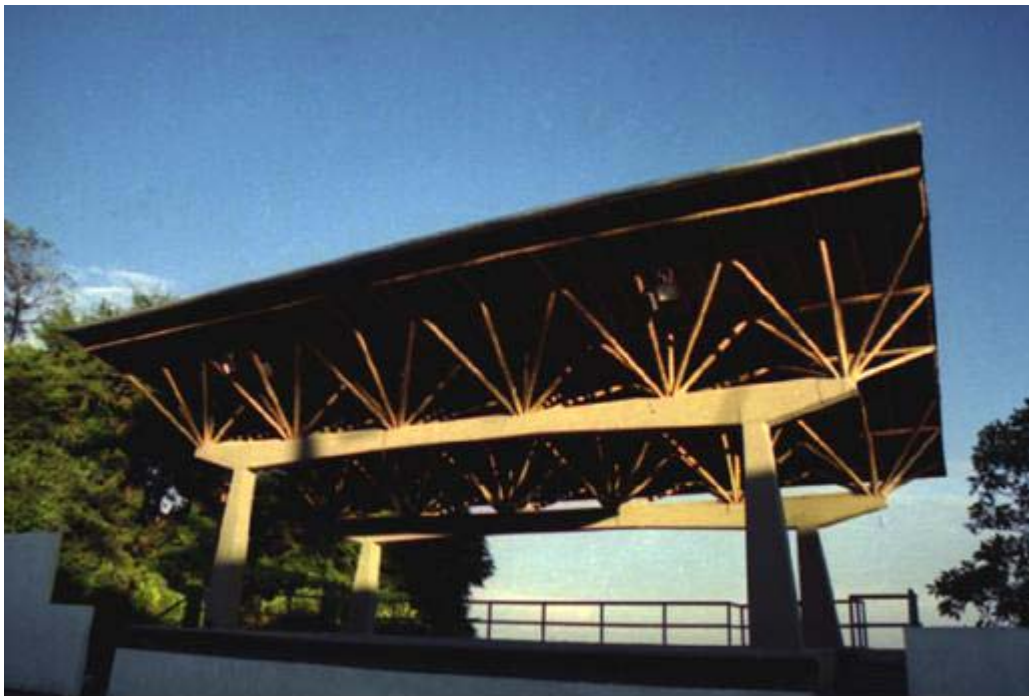
Ilustração 75: Bambu usado na estrutura de um abrigo.
