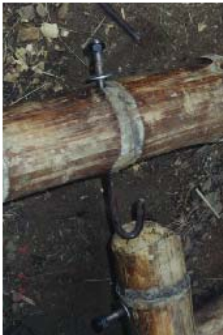
Ilustração 41: Fixação entre varas de bambu concretadas.
