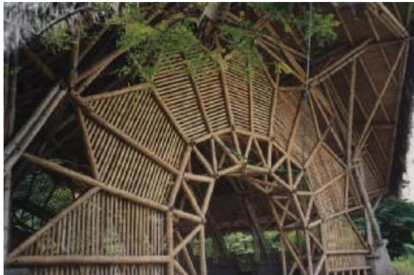
Ilustração 48: Fachada de um edifício na Colômbia, obra de Simon Vélez.
