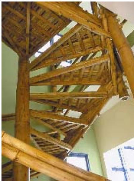
Ilustração 71: Bambu usado na estrutura de uma escada numa residência em Campo Grande, Mato Grosso.
