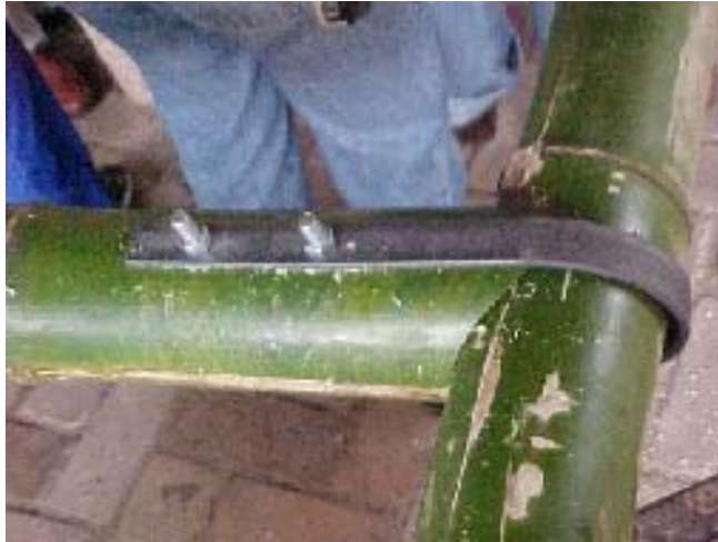
Ilustração 40: Fixação entre varas de bambu.
