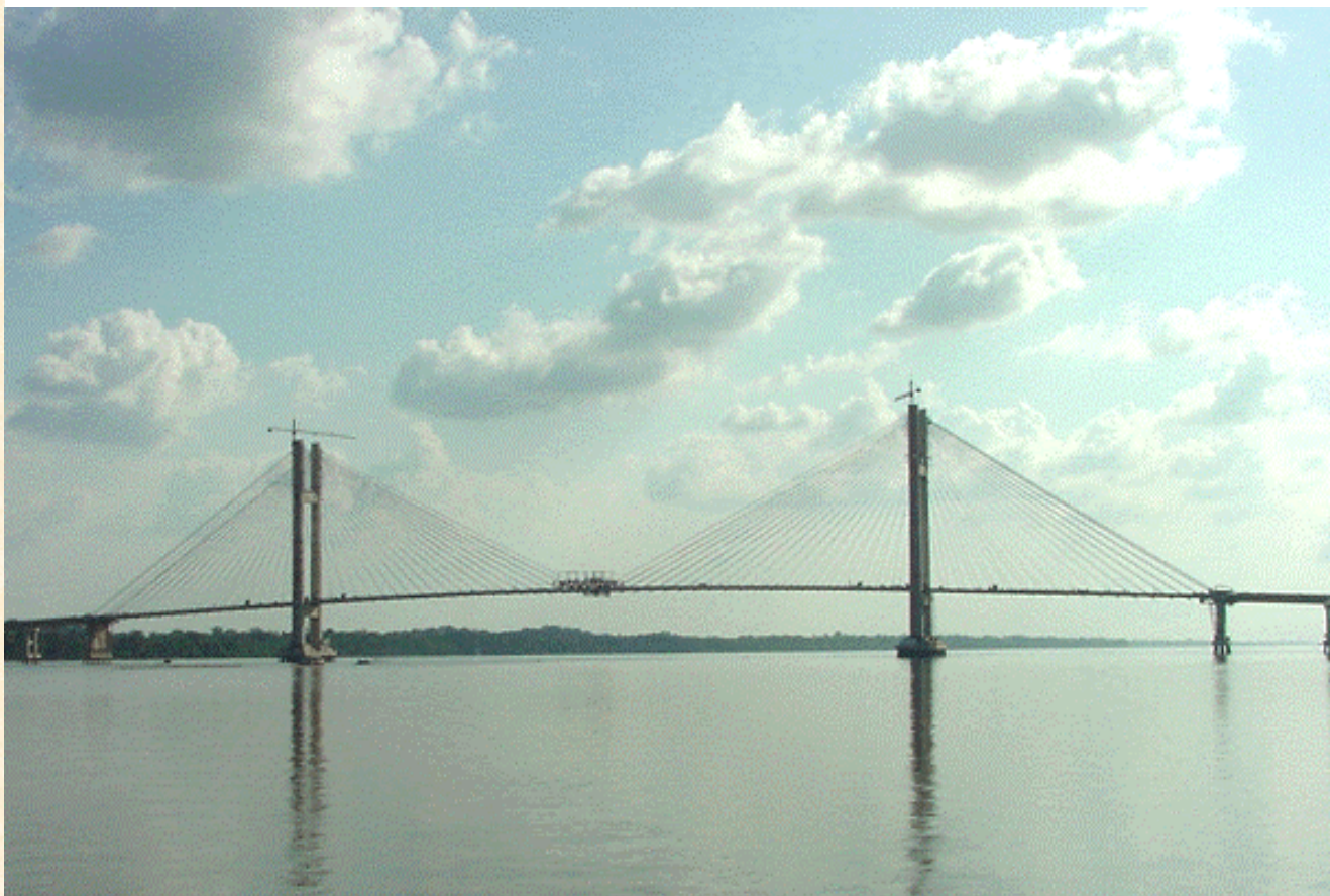
Ponte sobre o Rio Guamá em Belém – PA
