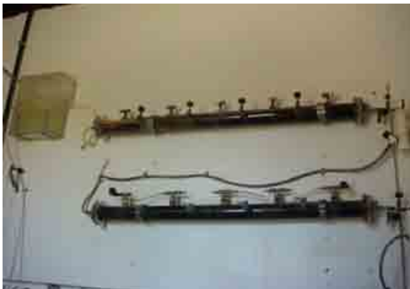
Figura 4.4 - Instalação experimental do sistema de tratamento com RAHC.
