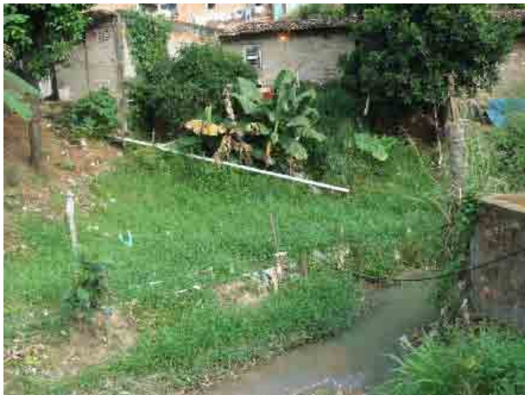
Ilustração 10: Caracterização típica de esgotamento sanitário clandestino com impactos ambientais relevantes para o rio. Ponto de coleta georeferenciado: 7 (fig.22)
