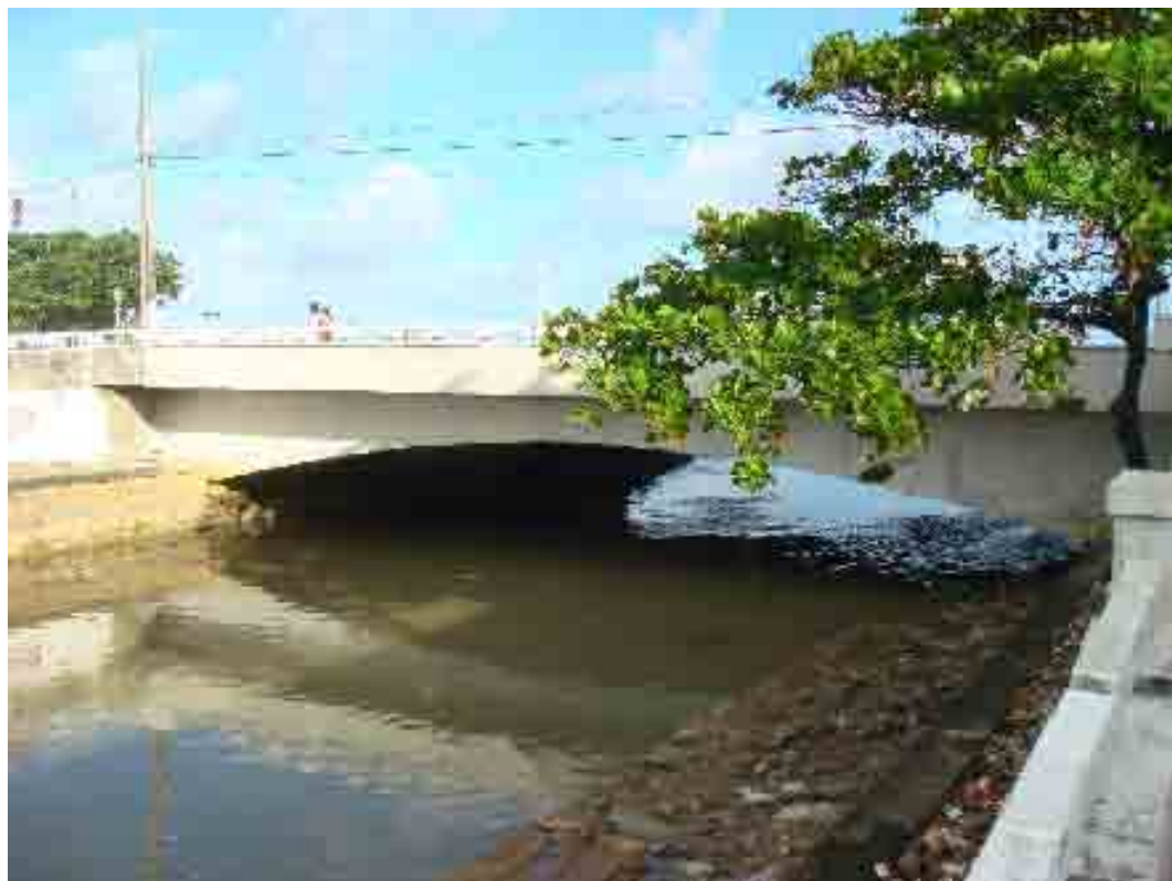
Ilustração 18: Ponte por cima do riacho de Salgadinho nos limites da Praia da Avenida no centro da cidade Ponto de coleta georeferenciado: 13 (fig.22)
