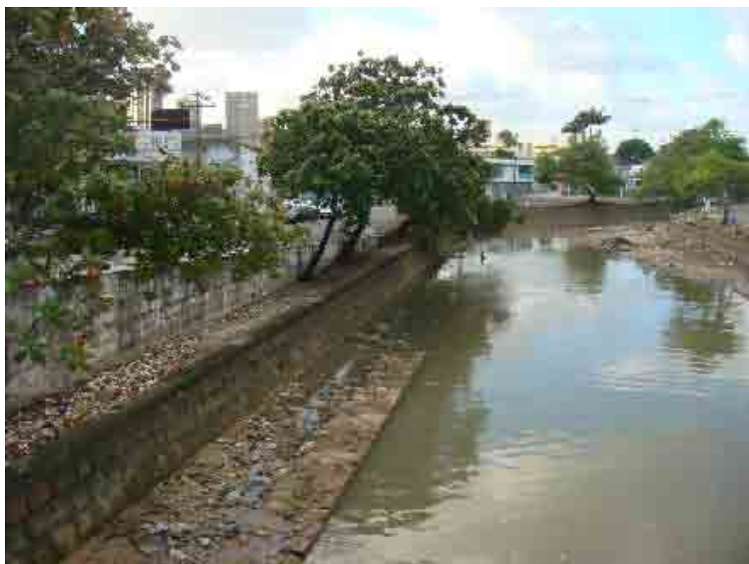
Ilustração 17: Caracterização da acumulação detrítica aluvionária no riacho Salgadinho provocada por eventos críticos pluviiais e assoreamento das margens Ponto de coleta georeferenciado: 12 (fig.22)
