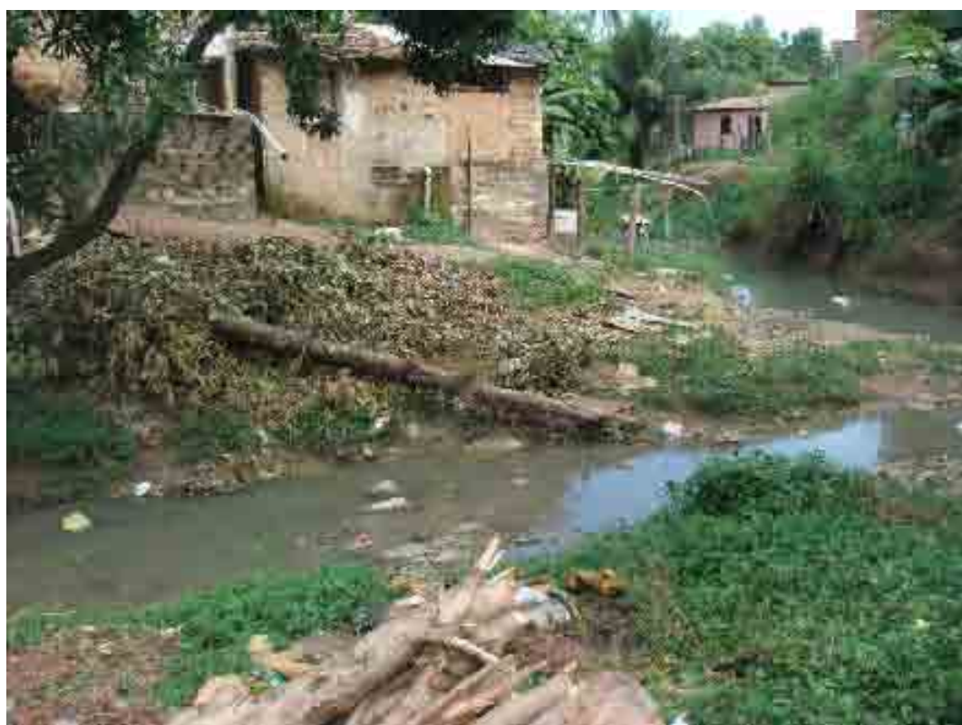
Ilustração 13: Várias canalizações residenciais ligadas ao rio Reginaldo Ponto de coleta georeferenciado: 10 (fig.22)
