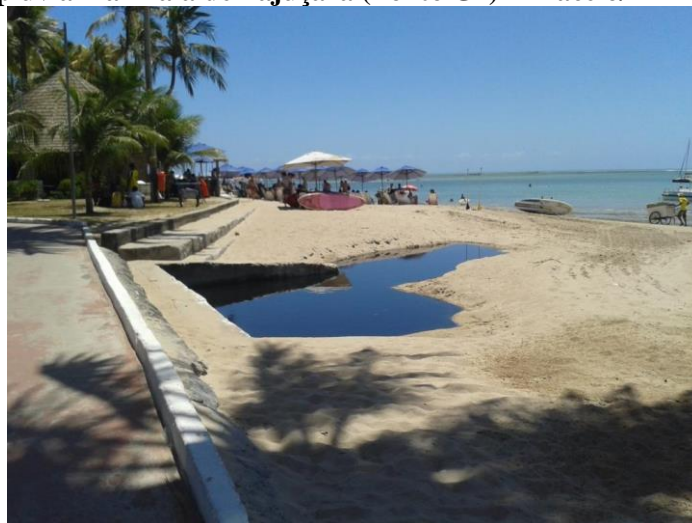
Figura 3 – Galeria pluvial na Praia de Pajuçara (Ponto G7) – Maceió/AL
